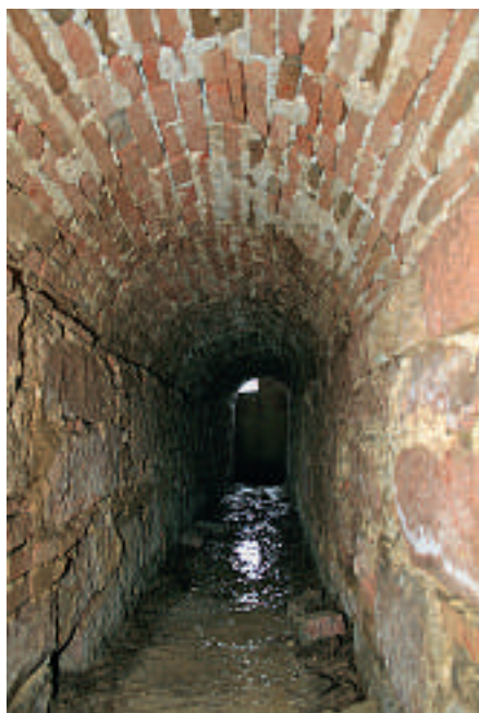
2 Hafnerquelle an der Margarethenstrasse Binningen: eine der 30 gemauerten Brunnstuben auf dem Gebiet der Gemeinde Binningen.
